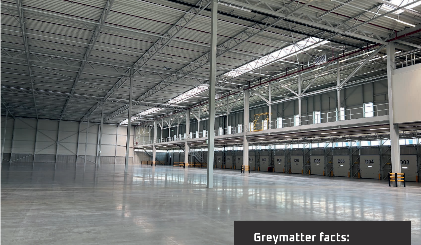
Deze, in februari 2025, opgeleverde vloer voor GLP Europe in Lelystad maakte Van Berlo met de Greymatter technologie. Hierdoor werd 27% CO 2 uitstoot bespaard. Voor dit project geeft Van Berlo een geverifieerde LCA af ter onderbouwing.
